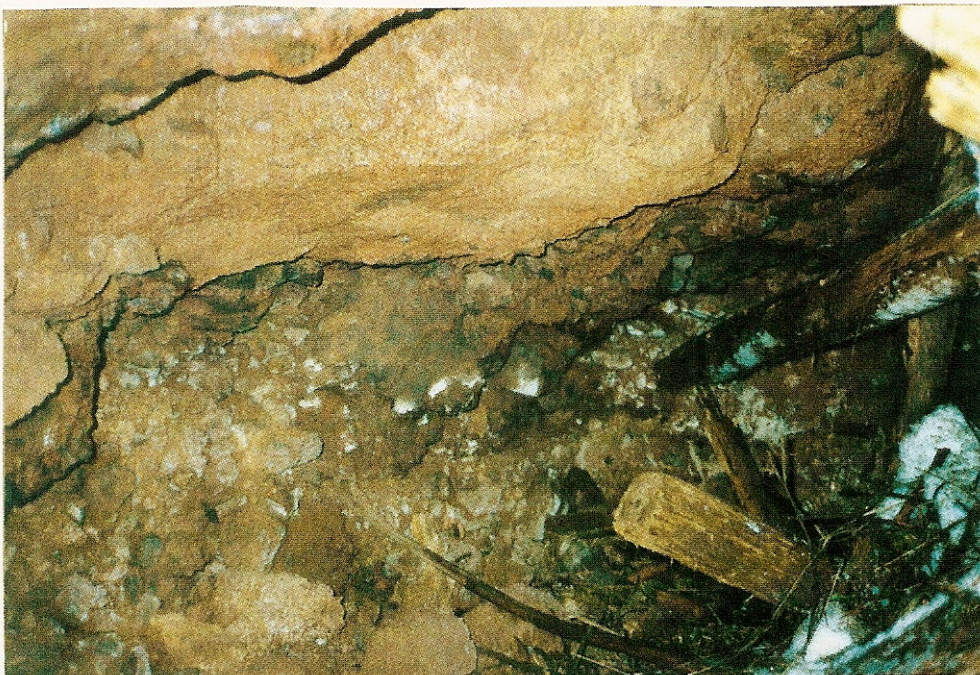
Blick in den eingestürzten Stolleneingang
