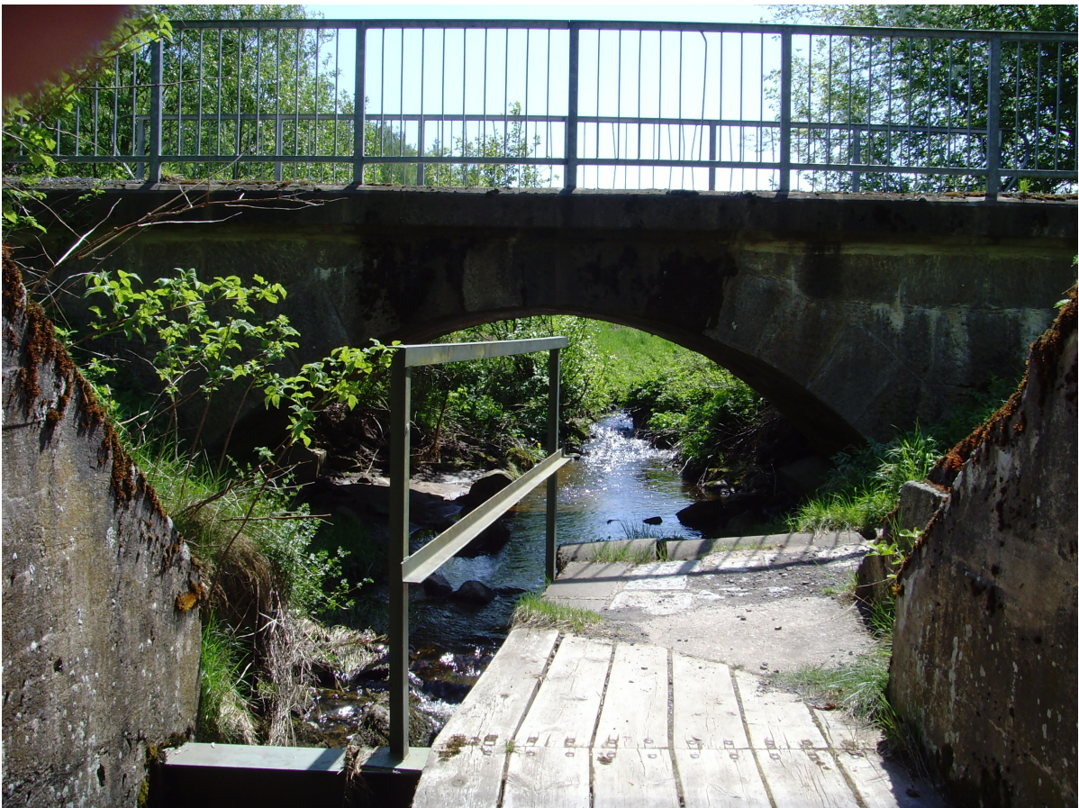
Blick aus dem Tunnel nach Süden, Richtung Kohlermühle. Die alte steinerne Brücke stammt auch noch aus der Zeit des Eisenbahnbaus. Nur das Gelände hat man zwischenzeitlich erneuert. Aufnahme 2007
